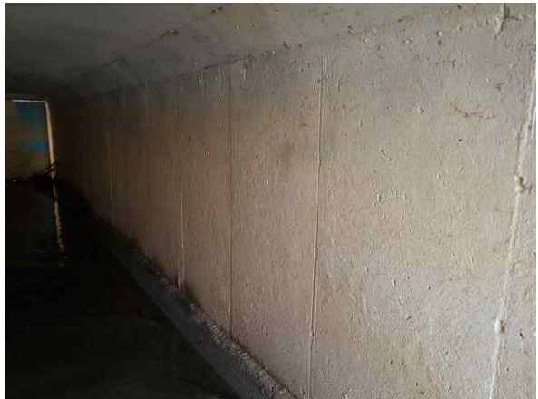
내부 벽체 현황(양호)
