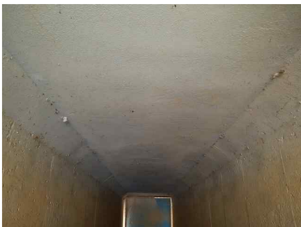
내부 슬래브 현황(양호)
